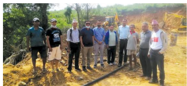
महेशमती त्रिवेणी रामघाट सडक निर्माण अनुगमन
