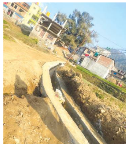
गणेशमार्ग चालिसे सडक पक्क नाली निर्माण
