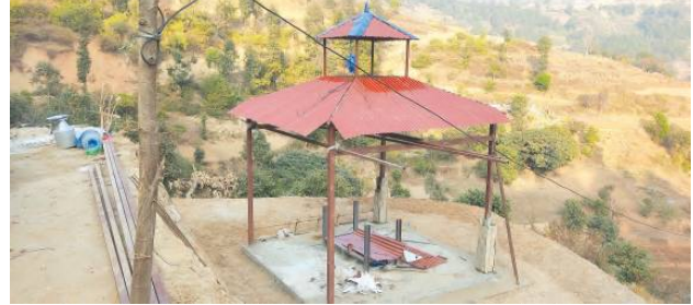
खरेल डाँडा ट्रष्ट निर्माण
