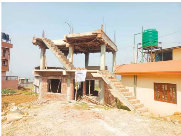
चैते क्रियापुत्री भवन निर्माण योजना
