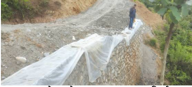
बगुवा झोलुङ्गे पुल सडकमा वाल निर्माण
