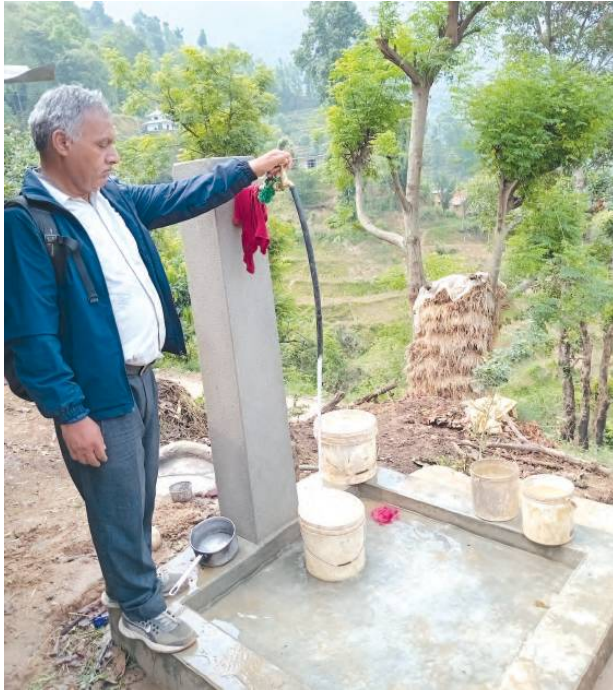
सिरानचौर खानेपानी एक घर एक धारा निर्माण निरीक्षण वडा नं. २
