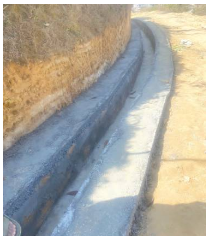
आधारभूत स्वास्थ्य केन्द्र सडक पक्क नाली निर्माण
