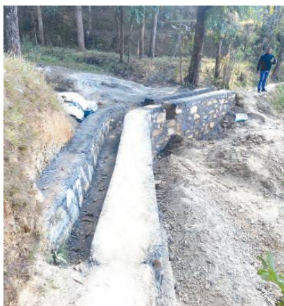
कल्चेफाँट पक्क कुलो निर्माण
