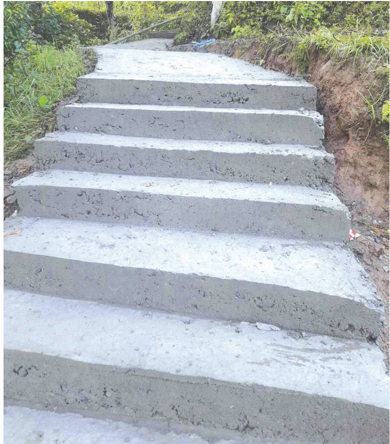
छाप गाउँ सिँडि निर्माण
