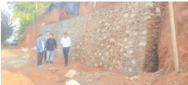
माथिल्लो मिजारगाउँ सडक वाल निर्माण
