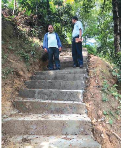
परियारटोल सिढी निर्माण टापु
