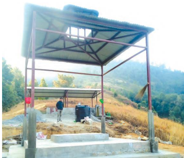
महाँकालेश्वरी मन्दिरमा वाल निर्माण तथा भागे चिहान डौडा ट्रस निर्माण
