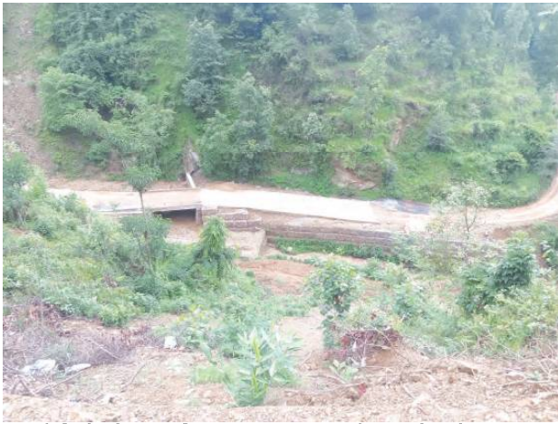
नौविसे दोभान लिखु सडक अन्तर्गत ठाडो खोलामा कल्भर्ट निर्माण तथा सडक ढलान
