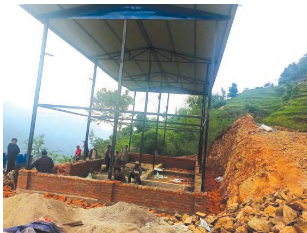
तोप्लाङ महिला भवन निर्माण
