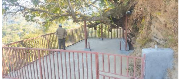
कोटाकालिका मन्दिर निर्माण
