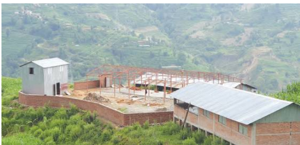
निर्माणाधिन बफेलो/काल्फ होस्टल धुनपा-१
