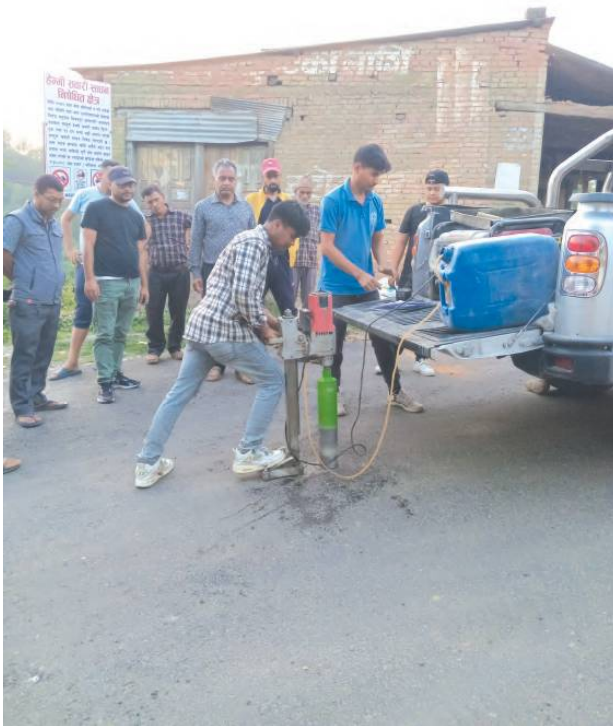
डाडा डी वढारेचौर जिवनपुर कोल्पु सडकमा कालोपत्रे कामको Core Cutting को काम हुदै
