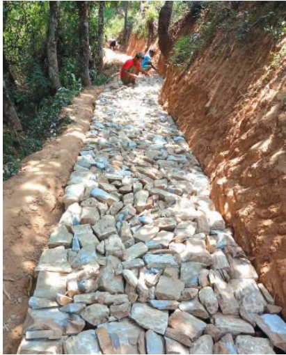
जिवनपुर गैरीगाँउ गोरेटो बाटो सिढी निर्माण
