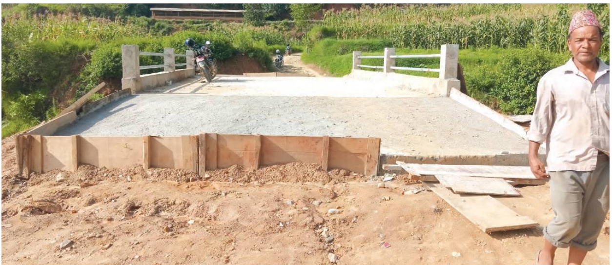
सिरानचोर महेशखोला पक्की पुल (कल्भर्ट) निर्माण भएको धुनपा- २
