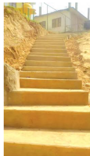
घर्तीगाँउ थुम्का गोरेटोबाटो सिढी निर्माण
