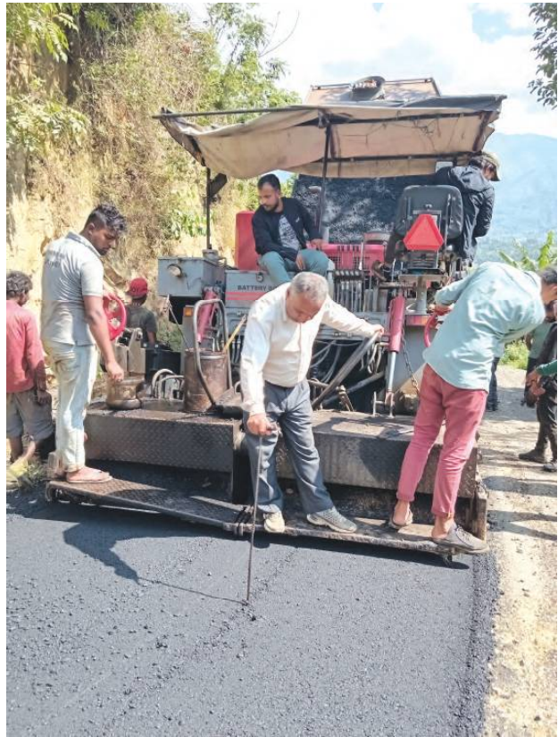
डाँडा डी वढारेचौर जिवनपुर कोल्पु सडकमा कालोपत्रे हुदै गर्दा इन्जिनियरद्वारा कालोपत्रेको कामको Thicknessपरिक्षण गर्दै
