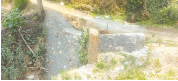
गैरीगाउँ रातमाटे सडमा पक्क वाल निर्माण
