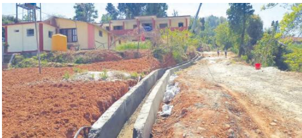
स्टोरमोड कोल्पुखोला आर.सि.सि. नालि निर्माण
