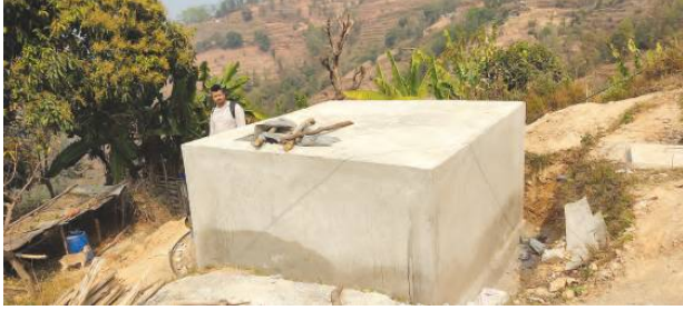
दलित बस्ती खानेपानी ट्याङ्की निर्माण
