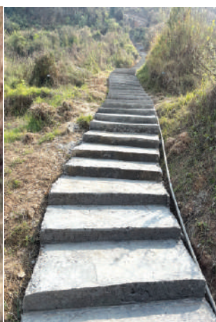
साधिखोला पुजारी मोड मरणघाट सिढी निर्माण धु.न.पा. ३
