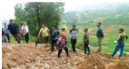
वडा नं. २ र ९ का जनप्रतिनिधीद्वारा वर्षातको पहिरोले बिप्रेको पिपलामोड कान्ले भदौरे सडक खण्ड अवलोकन
