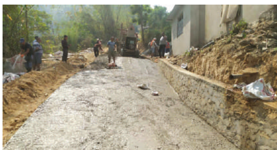
तल्लो सिरानचौर माथिल्लो सिरानचौर सडक निर्माण योजना
