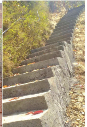
सयले गौचरण कालीदेवीस्थान सिढी निर्माण धु.न.पा. ६
