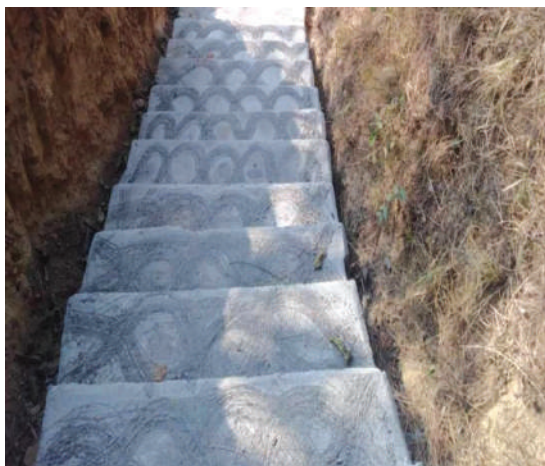
सुनरगाउँ नाकेडाँडा गोरेटो बाटो निर्माण
