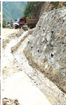
पिपलामोड महेशफाँट सडक टेवा वाल तथा नालि निर्माण
