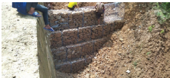
काफलचौरमा पहिरो नियन्त्रणको लागि ग्याबिनवाल निर्माण
