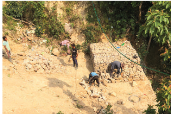
कोलकाटे खेल मैदान ग्याविन जाली निर्माण
