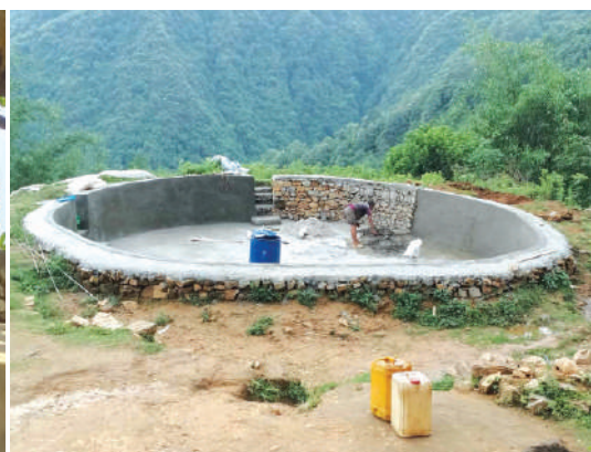
पोखरी डाँडा पोखरी पि सि सि र प्लास्टर धु.न.पा. ७
