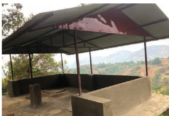
सुन्दरादेवि मन्दिर(कोटडाँडा) पाटी भवन ढलान तथा ट्रेस निर्माण
