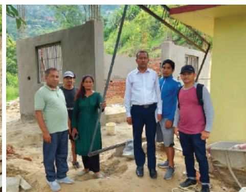
गौरी शंकर मन्दिर गुरुकुल भवन निर्माण
