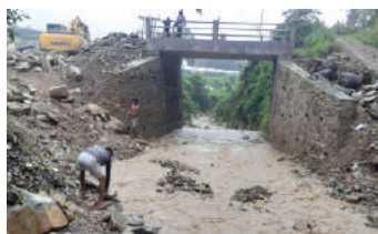
सिक्रेखोला कल्भर्ट निर्माण
