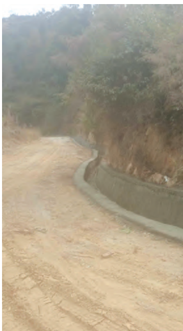
जिवनपुर कोल्पुखोला सडक पक्की नालि
