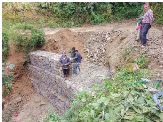
निगालेभिर सडक निर्माण
