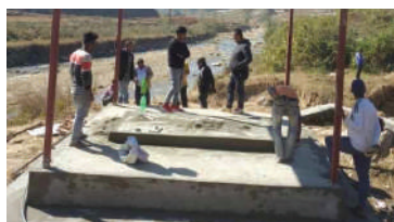
तामाङ समाधि स्थल निर्माण
