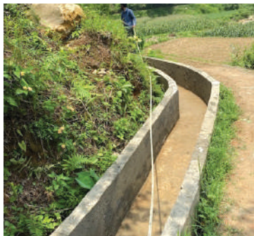
काभ्रे कुलो निर्माण
