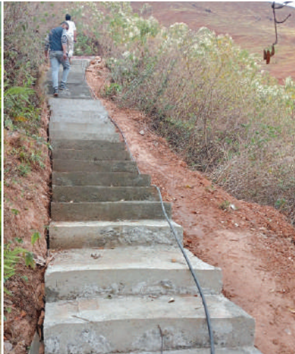
पुरनडाँडा जंगलेखोला छत्रेपाटी सिढी निर्माण योजना धु.न.पा. ३
