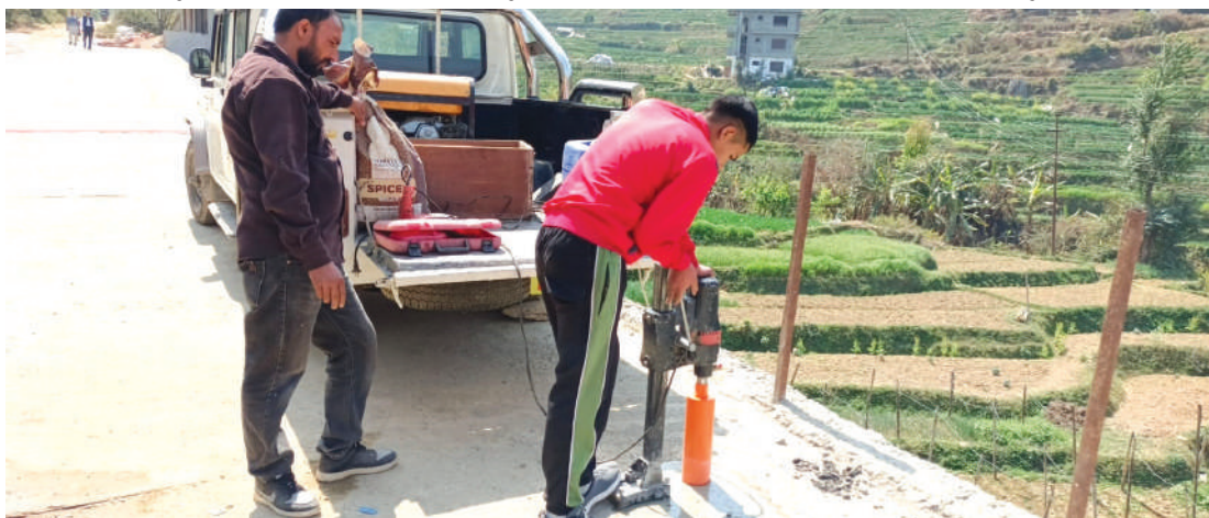
खानीखोला-गणेशमार्ग-काफलचौर सडक ढलानको कोर कटिङ्ग
