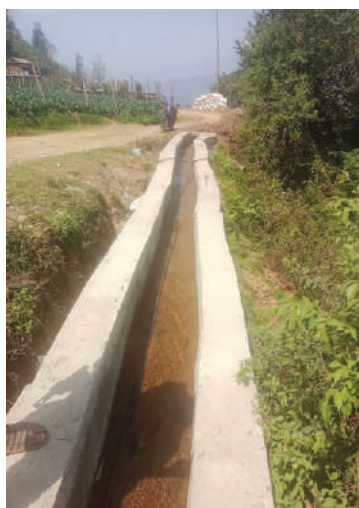
बाँसुकी फलामे कुलो निर्माण
