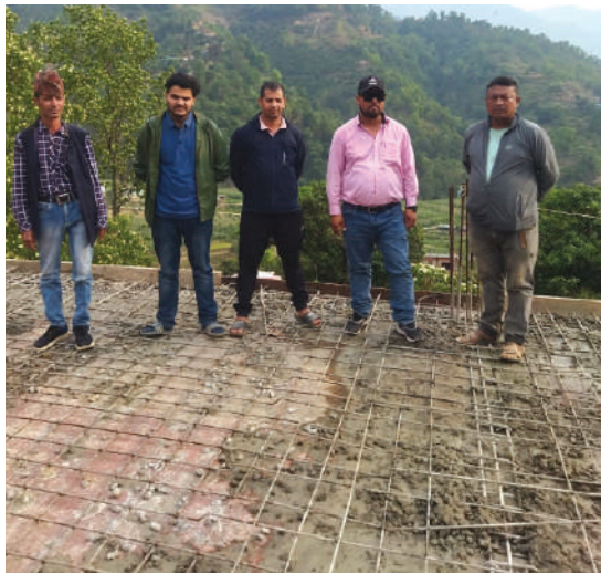
पशुपन्डी प्रयोगशाला भवन ढलान कार्य निरिक्षण
