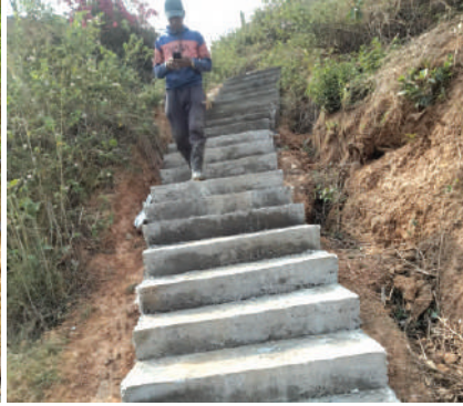
कुडुले सिढी निर्माण धु.न.पा. ८
