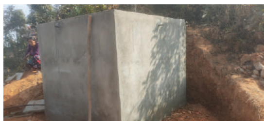
सानो कुसुन्डे खानेपानी ट्यांकी निर्माण
